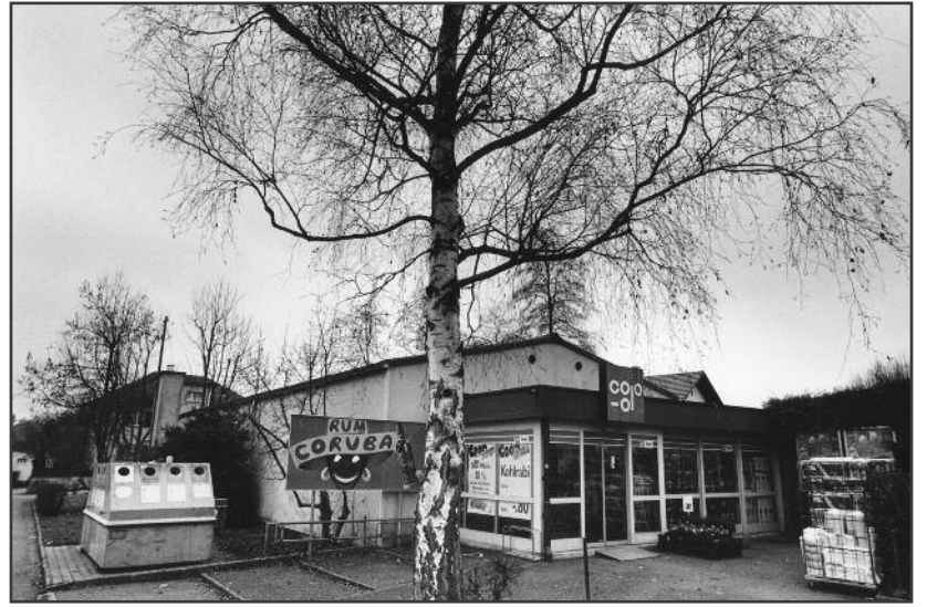
Nach dem Wegzug aus der Stammliegenschaft wirtschaftete die Coop 30 Jahre lang in einem «Providurium» an der Ecke Lindenstrasse/Ritterstrasse. (Archivbild Hansueli Trachsel)
